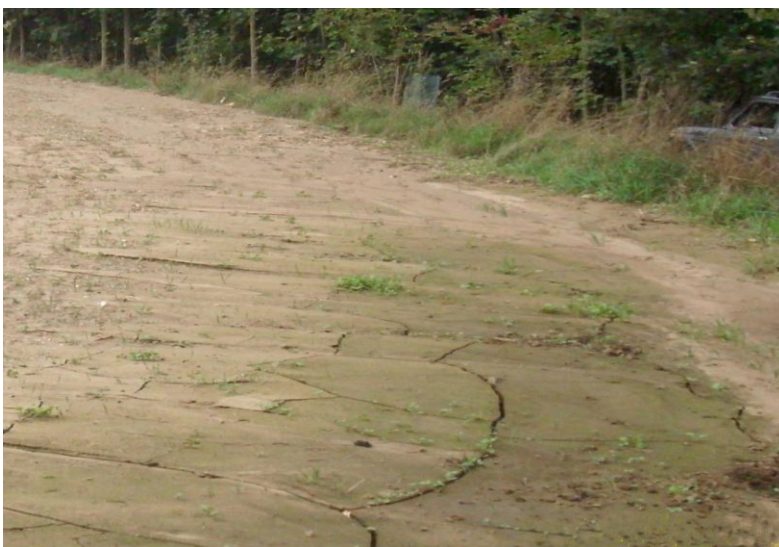
Obrázek 4: Spodní část pole s průduchy zanesenými jemnými částicemi. Zdroj: Monitoring eroze zemědělské půdy
