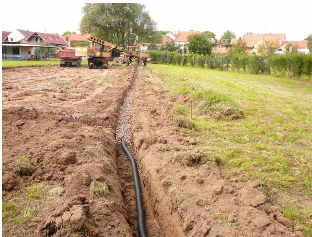
Obrázek 10: oprava melioračního potrubí. Zdroj: Oficiální stránky obce Chotutice.
