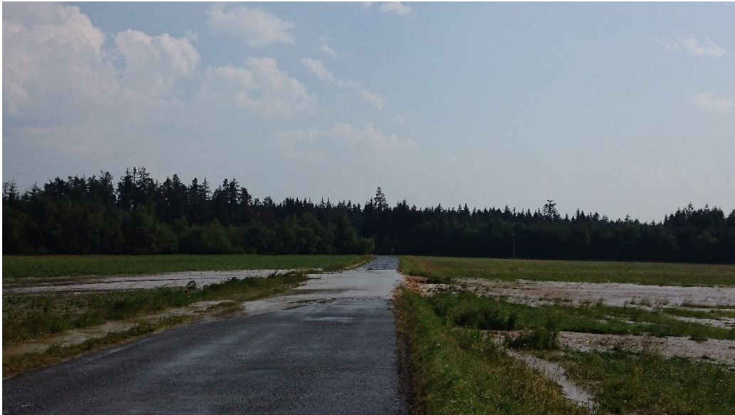
Obrázek 3: Letní erozní událost (povrchový odtok vznikl po dešti na poli s dosud nevzrostlou kukuřicí, ucpal potrubí pod povrchem vozovky a zaplavil místní komunikaci).
