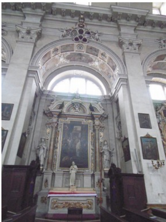
13. Stará Boleslav, kostel Nanebevzetí Panny Marie, 1617-1623, Lažanská kaple
