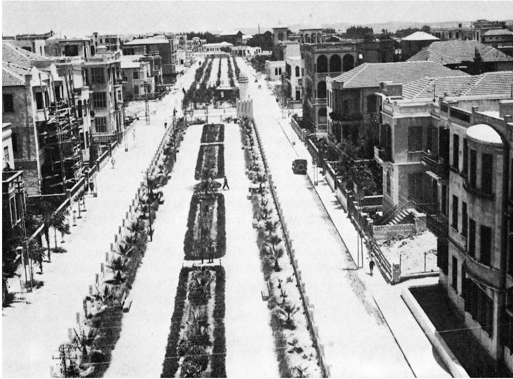
Obr. 6. Budovy ve výstavbě na Rothschildově bulváru, nedatováno
