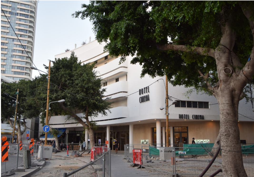
Obr. 24. Podoba náměstí během rekonstrukce v roce 2017; Hotel Cinema, bývalé kino Esther (arch. Yehuda Magidovitch) Dizengoff Square 10, 1939
