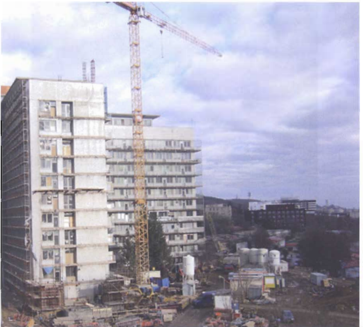
Pohled na rekonstrukci dětské části FN Motol.
