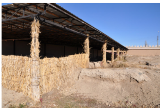
Stavba na území karavanseraje Tortkul
